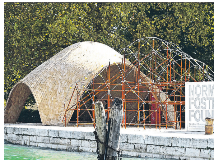
C'est à la Fondation Norman and Elena Foster à Gilly que les droneports devront leur architecture.
